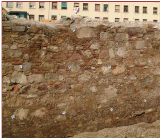
Detall del procés d'instal·lació de les dianes de l'aixecament planimètric
