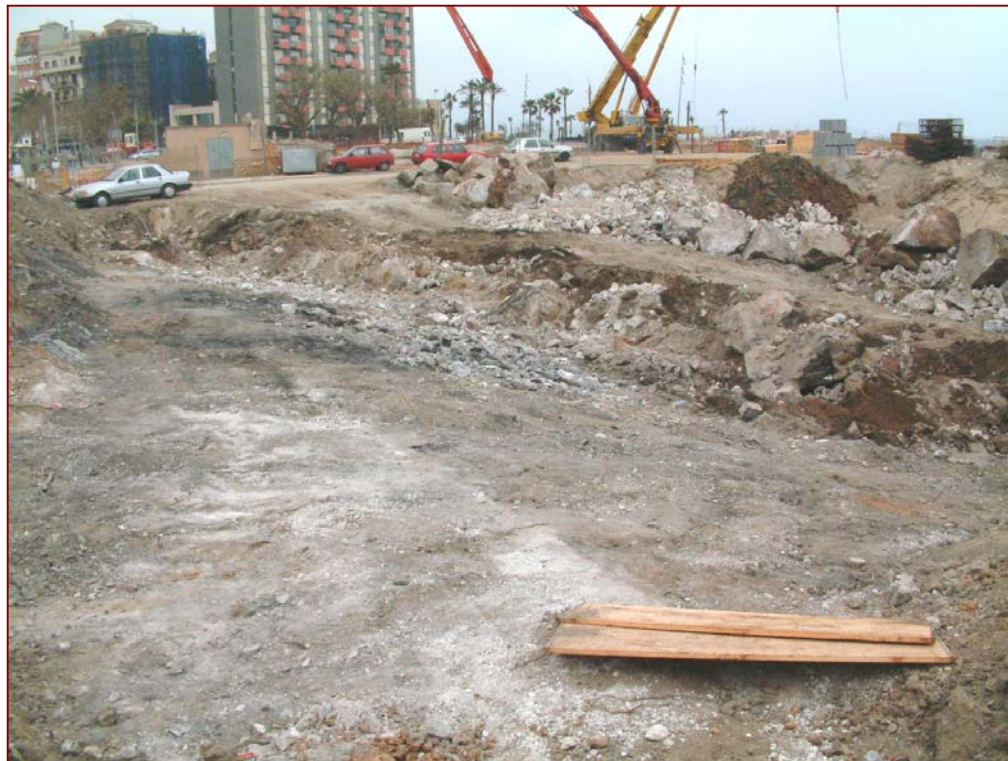
Vista general del jaciment un cop finalitzats els treballs de desmuntatge de les estructures aparegudes
